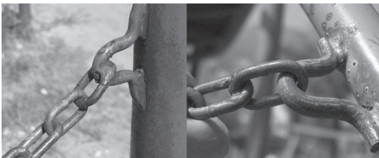
Figura 6: Detalhe de fixação das correntes
