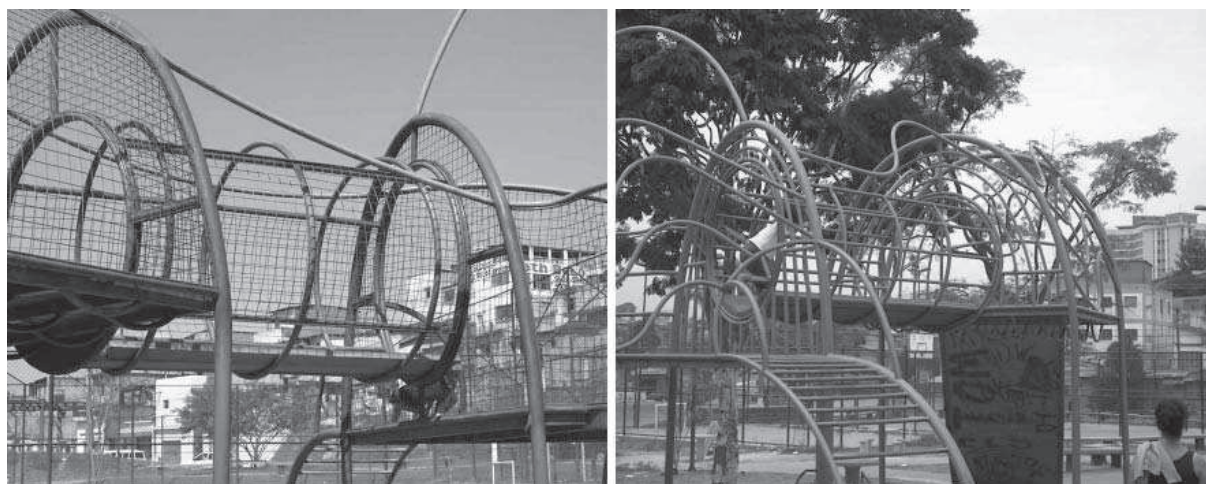
Figura 4: Corrimãos, guarda-corpos e barreiras. Os guarda-corpos e corrimãos são formados por tubos redondos de 1" e 1 1/2" soldados aos pórticos e às divisões internas dos pórticos. As barreiras são formadas por telas de arame galvanizado 50 x 50mm soldados em uma barra de aço de diâmetro de 6,3mm e fixadas ao guarda-corpo e à estrutura. Foram colocadas barreiras na plataforma do escorregador, na do escorregador de bombeiro e no túnel que liga essas duas plataformas.
