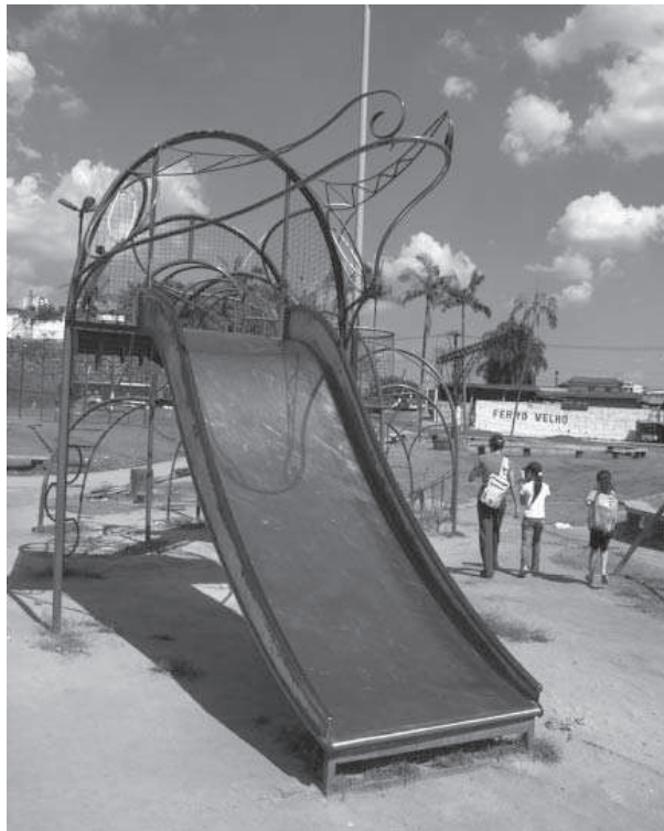
Figura 2: Brinquedo jacaré, escorregador. Dois tubos de aço de 2 1/2" curvos, ligados por tubos de aço quadrados, formam a estrutura de apoio da chapa de inox do escorregador que tem 1,20m de largura e comporta mais de uma criança ao mesmo tempo.
