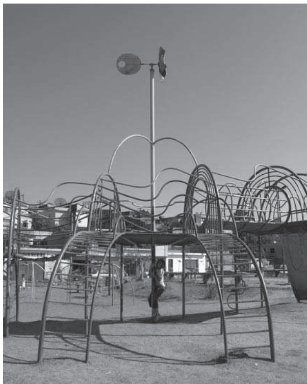
Figura 3: Brinquedo jacaré, mastro escorregador de bombeiro, feito com tubo de aço de 4" fixado à fundação através de solda em esperas chumbadas no concreto.
