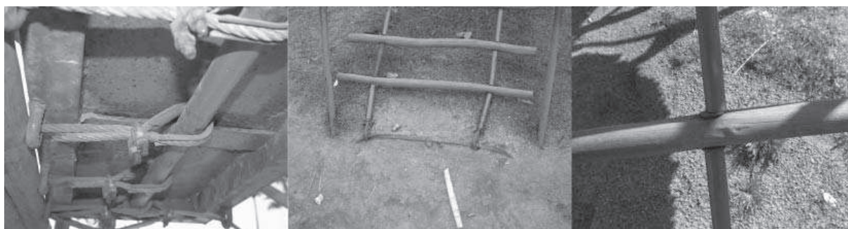
Figura 5: Detalhe da fixação dos cabos de aço da estrutura do brinquedo, da fixação dos cabos de aço na parte inferior da escada de madeira e do espaçador feito de tubo de aço para os degraus de madeira roliça.
