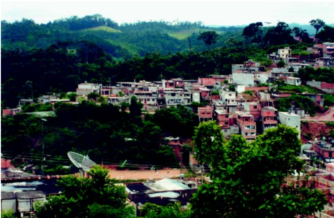
Foto 4: Ocupações irregulares na área de proteção dos mananciais, Represa Billings Crédito: LabHab
