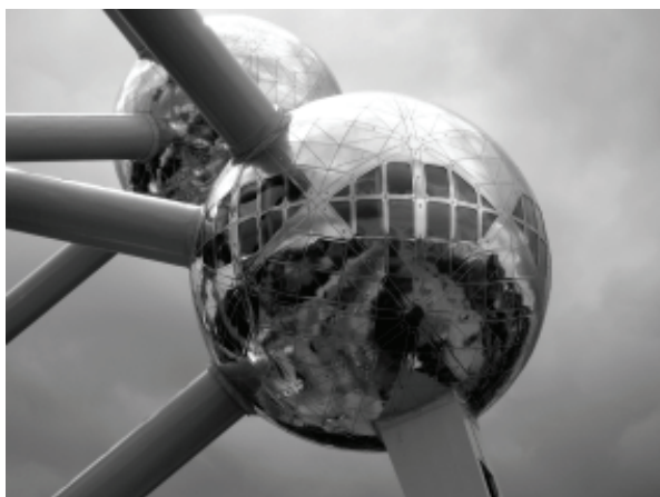
Figura 24: Bruxelas, Atomium (A. Waterkeyn, 1958). A construção, depois dos trabalhos de reabilitação realizados entre 2000 e 2005. A intervenção foi definida como “restauro”, mas o que se concretizou, de fato, foi um refazimento quase integral. A recente intervenção feita nessa construção singular consistiu na substituição total das chapas de revestimento das esferas, na consolidação da estrutura metálica portante, na revisão da sistematização interna e na adequação das instalações. Na substituição das velhas chapas por outras novas e brilhantes – com materiais tecnologicamente avançados – à base de poliuretano e utilizando, no interior, materiais para isolamento termo-acústico, centra-se a intenção de reconduzir a construção a seu estado original e, portanto, de reapropriar-se do símbolo de uma época de ouro para a Bélgica. Isso mesmo a custo de eliminar parte essencial da construção, na qual se condensava o real valor da obra: a utilização do metal a serviço da engenharia e da construção que, no Atomium, encontra um admirável e ousado exemplo. As chapas de revestimento, uma vez desmontadas, foram vendidas e compradas por colecionadores privados, improváveis “antiquários”, e por jovens artistas para juntá-las em novas formas artísticas. Por um lado, pois, não se tolera o aspecto envelhecido da pele do edifício, patinado e não mais reluzente como antes; por outro, seus pedaços, reduzidos a fragmentos, adquirem valor de relíquia ou, descontextualizados, são elevados ao patamar anistórico de objet trouvé Crédito: Foto de Beatriz M. Kúhl, 2006
