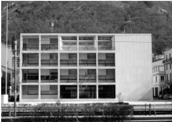
Figura 28: Ex-Casa del Fascio (G. Terragni, 1932-1936); fachada principal depois do restauro. A intervenção, dirigida por Alberto Artioli entre 1988 e 1992, por iniciativa da Soprintendenza per i Beni Architettonici de Milão, consistiu de tradicionais operações conservativas (limpeza, consolidação, proteção) para remediar os danos causados no revestimento de placas de mármore botticino por uma inábil manutenção dos anos 60. Após a remoção das resinas de silicone velhas e enegrecidas usadas para selar as juntas, e sua substituição por argamassas tradicionais, controladas do ponto de vista técnico, realizaram-se operações minimamente invasivas com o intuito de eliminar as causas de degradação. O rigoroso respeito por uma metodologia conservativa permitiu restringir as intervenções e as substituições, limitadas a poucas placas não-recuperáveis Crédito: Foto de Alessandra Cerroti, 2006
