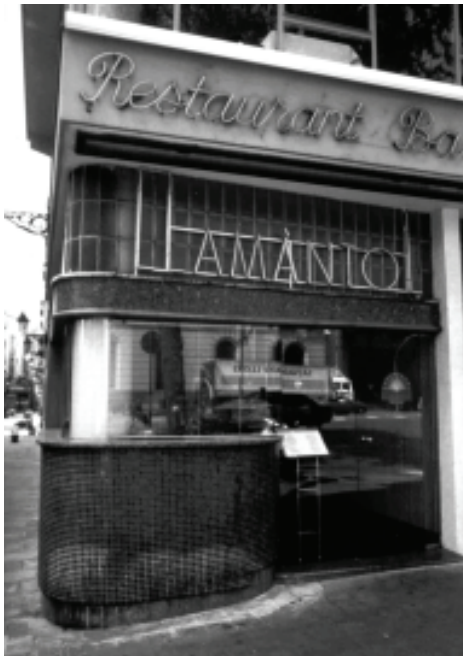
Figura 26: Barcelona, Hotel Park (A. Moragas e Galissa, 1950-1954), pormenor do bar na fachada principal. A intervenção foi projetada e dirigida, entre 1988 e 1990, pelo filho do autor, seu homônimo, com a intenção de recuperar a obra do pai, danificada pelo tempo transcorrido e pela falta de manutenção. A insólita circunstância de “restaurar” a obra do próprio pai conduziu Moragas a profundas reflexões no que concerne à legitimidade de reconstruir uma obra de arquitetura tão recente. A intervenção foi conduzida em “duas velocidades”, segundo a parte na qual se intervinha: na zona dos quartos, adotou-se uma postura mais livre, devida também à necessidade de adequar os ambientes às normas e exigências atuais, sem, no entanto, exceder-se; as áreas comuns, ao contrário, tais como o hall , o bar, as escadas principais, o revestimento externo da fachada principal, o restaurante e a sala de leitura, dotados de detalhes arquitetônicos originais, de acabamento e de bens móveis, integrados ou não, projetados e realizados com particular cuidado, foram plenamente respeitados e conservados em sua forma, matéria e no estado, mesmo consumido pelo tempo, em que se encontravam. O resultado é de grande harmonia, pelos êxitos estéticos e pela atenção dada ao pormenor, denso de história, pessoal e geral Crédito: Foto de Simona Salvo, 1998
