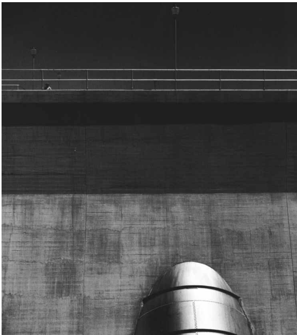
Figura 5 – Thomaz Farkas (FCCB) – Barragem de usina / 1951. Acervo do fotógrafo no Instituto Moreira Salles.
