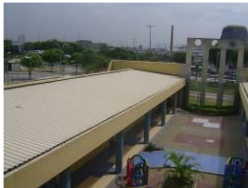
Figura 19 - Pátio Central em claustro. (Fonte: Blower, 2008)
