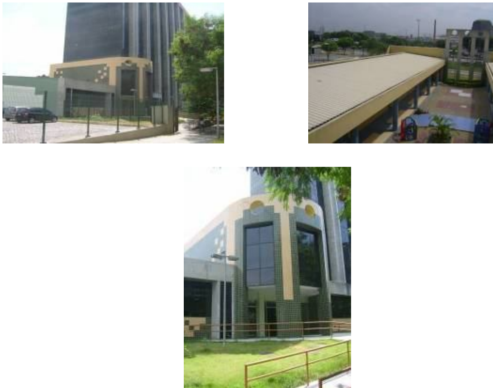
Figura 4 – Fachadas Creche Institucional da Prefeitura – R. Afonso Cavalcanti (Fonte:Blower, 2008)
