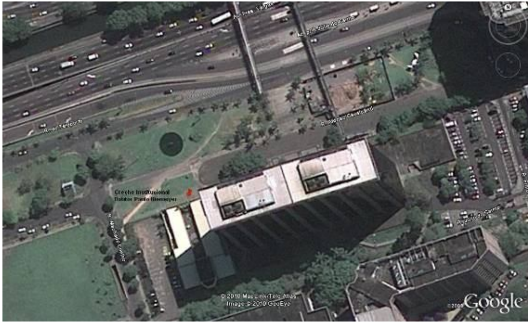
Figura 1 – Localização Creche Institucional da Prefeitura (fonte: Google Earth - acesso 22/03/2010)
