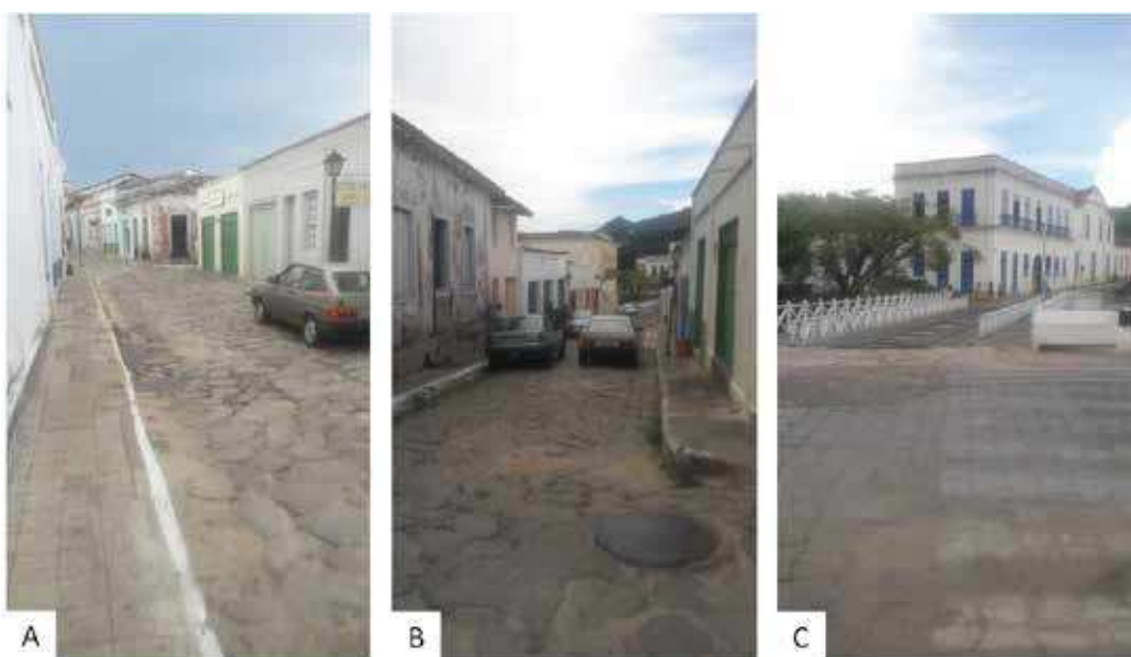
Figuras 12-A, 12-B e 12-C Trechos entre a praça do Coreto e a rua do hospital. Fotos: Carina Cardoso, 2016.
