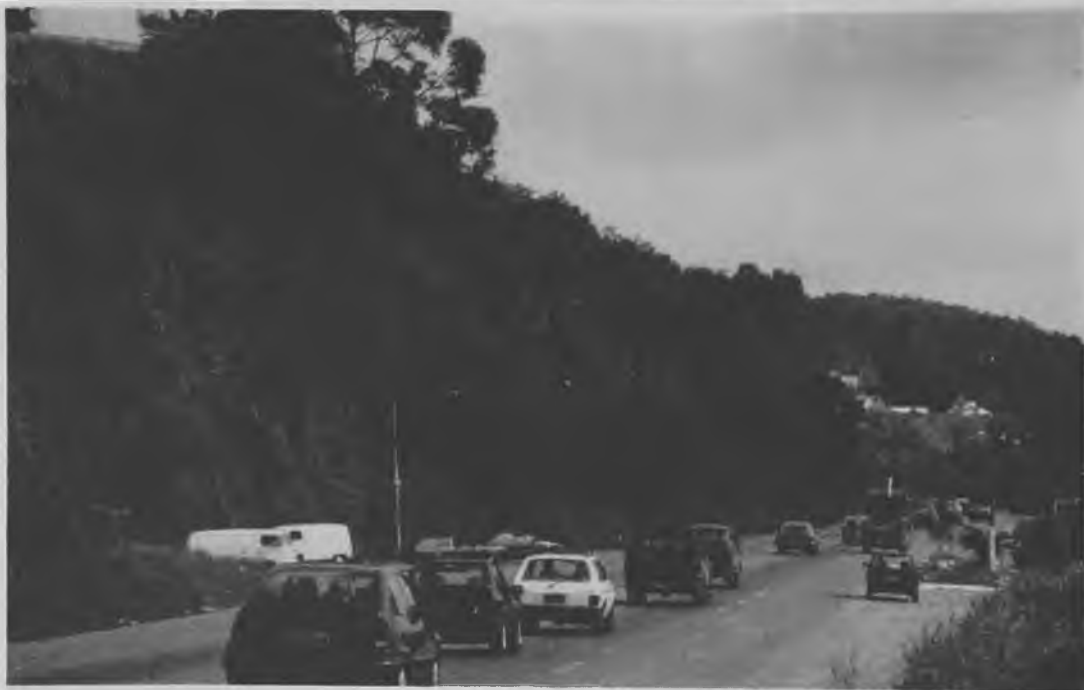
Intersecção com a rodovia SP88, no km 80. Observa-se aqui a extrema falta de segurança na travessia, tanto pelo tráfego intenso, como pelas condições precárias de visibilidade, o que exigirá remodelação total do traçado.
