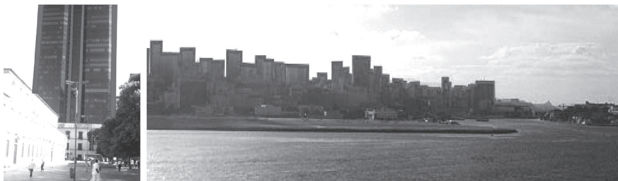
Figura 1: Edifício da Cândido Mendes, visto a partir da praça XV, Rio de Janeiro (esquerda) e o mesmo edifício visto da baía de Guanabara, inserido no conjunto de prédios do centro da cidade Fonte : FEGHALI, 2005
