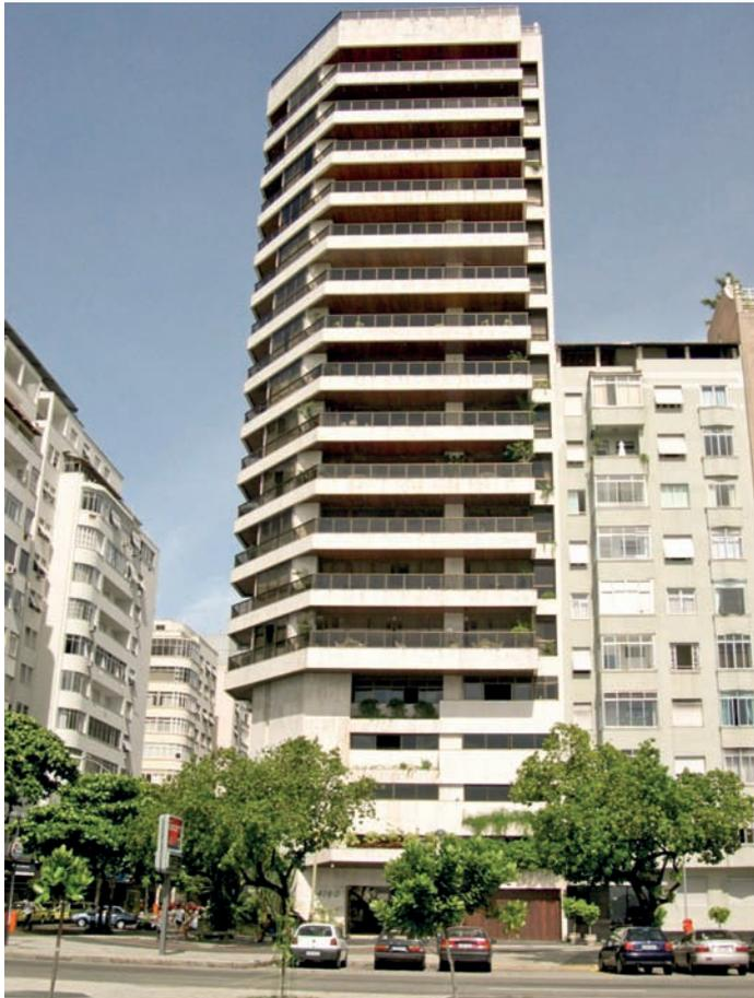
Figura 7: Edifício com o embasamento onde o 1º andar de apartamentos passa a estar a cinco pavimentos de distância acima do nível da rua
