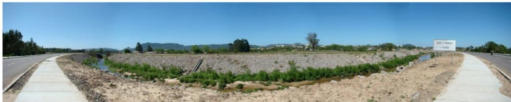
**Figura 13** Construção da avenida Dom Ivo Lorscheister em Santa Maria (RS). Obra do Programa de Aceleração do Crescimento (PAC) realizada mediante aterro de áreas da planície de inundação do Arroio Cadena, exigindo a remoção de mata ciliar e a canalização e retificação do Arroio.
