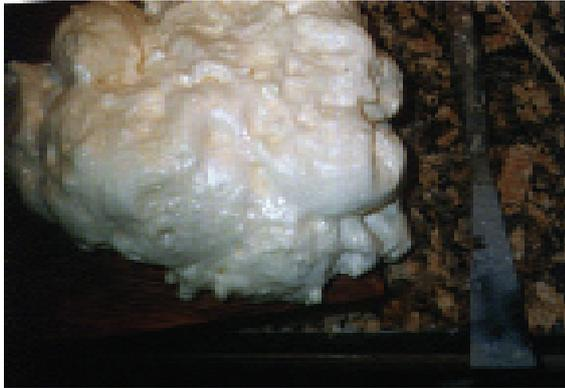
Figura 3: Cobertura com espuma de poliuretano
