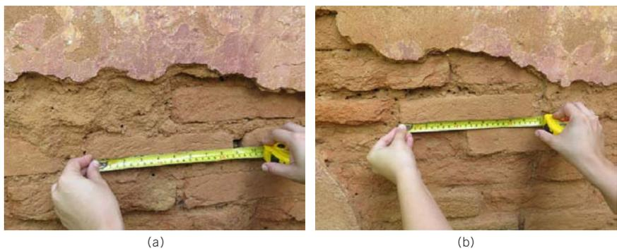
edificação 01. Nos trechos em que os tijolos estão aparentes, a variação das peças oscila entre 1 a 2 cm no comprimento e na altura (Figura 5). Dessa maneira, com relação à amostragem, os tijolos possuem dimensões que variam entre 21 a 26 cm de comprimento, 13 a 15 cm de largura e 5 a 7 cm de espessura.
