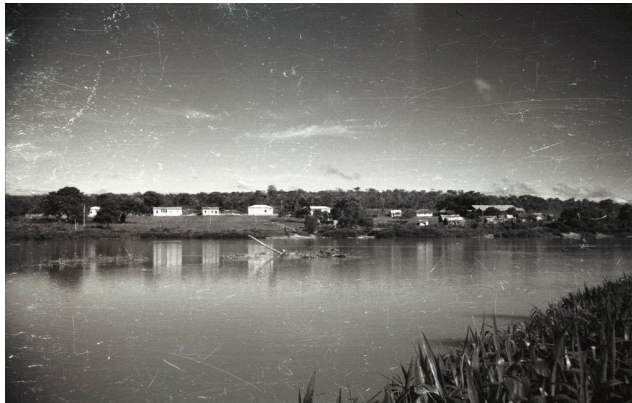
Imagem SPI02864 – Vista geral do Posto Indígena São Lourenço. Da esquerda para direita: estação telegráfica, escola, casa do encarregado (sede da Colônia Militar), casa de hóspedes, hospital (em construção), casas dos empregados, casa de máquinas e aldeia. São Lourenço. Heinz Foerthmann, 1943.
