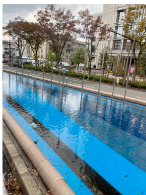
Figura 6. Canal urbano tratado em Quioto, Japão. Foto A. em 16 nov. 2023
