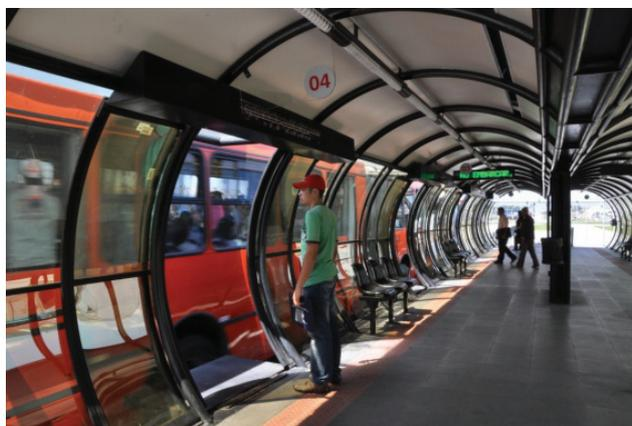
**Figuras 4 e 5** – O primeiro sistema BRT em que mostra suas linhas exclusivas e alinhamento no centro das vias. No detalhe, o acesso da plataforma ao ônibus em nível. Ambos os procedimentos para reduzir atrasos no embarque e desembarque. Fonte: <<http://www.brtrbrasil.org>>.
