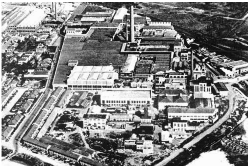
Vista aérea das instalações do antigo grupo Matarazzo
