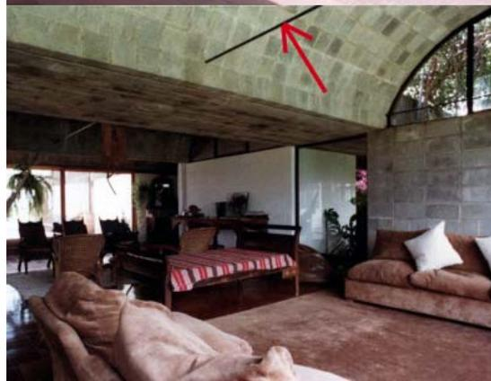
**Figura 17:** Entre as abóbadas, blocos-verga em 'U' e lajotas de 3,0 cm de espessura formam um conjunto rígido, que vence vãos de até 6,0 m ou balanços de até 2,0 m de comprimento. Fonte: MARCOS ACAYABA ARQUITETOS, 2007.
