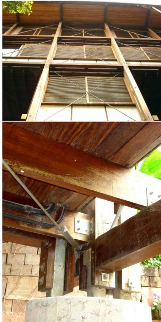
**Figura 28:** Contraventamento vertical na fachada e horizontal fixado ao nó estrutural abaixo do piso. Fonte: autora.
